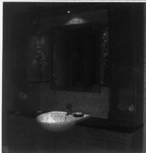
Avant d'installer de nouveaux meubles et appareils dans la salle de bains, il faut s'assurer qu'il n'y a pas de problème d'humidité.
