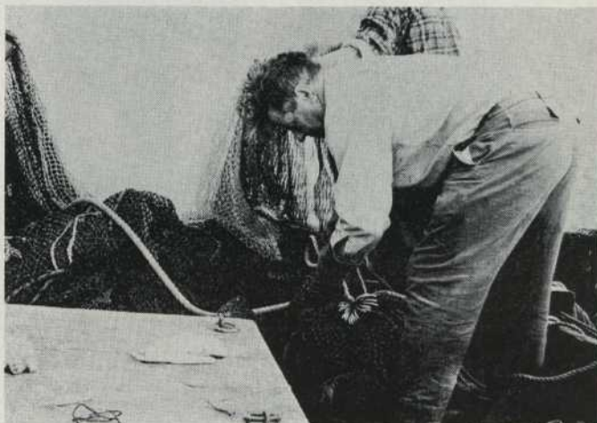
Fig. 3 (en haut). Il est important de bien nouer la poche du chalut ou le « cod-end ».
