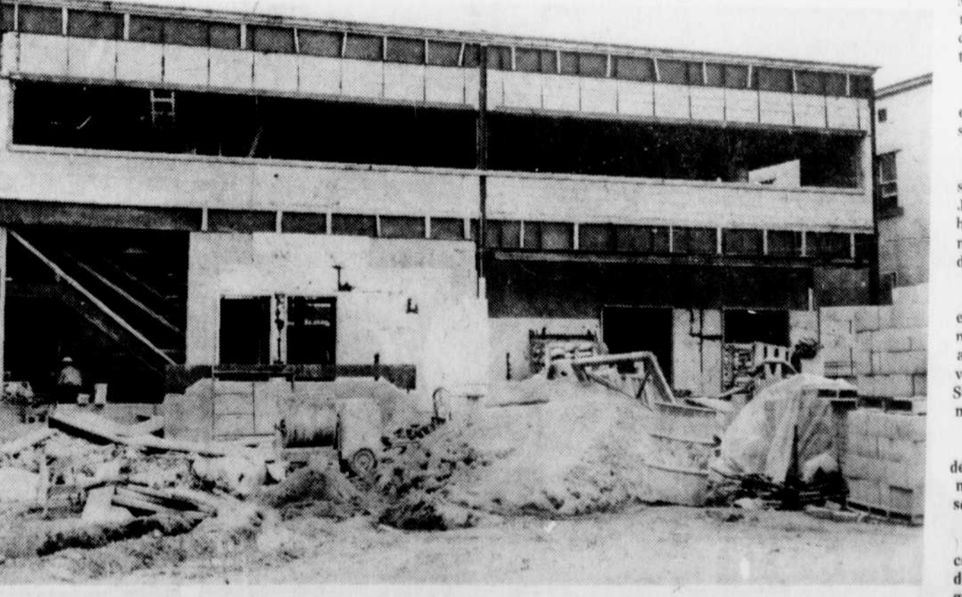
L'arrière du bureau de poste en construction à Lac-Mégantic. (Photo La Tribune par Richard Vigneault)
