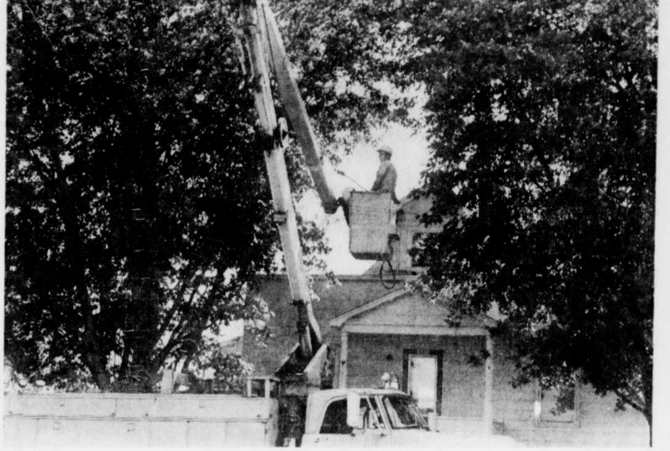
Afin de prévenir le bris de fils électriques dans la ville d'Asbestos, les employés municipaux se sont affairés à couper les branches d'arbres qui se trouvaient trop près des fils électriques. A l'aide d'une cisaille et de cette échelle hydraulique, ce travail s'est fait assez rapidement.
