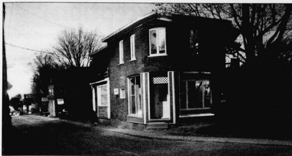
La maison que la Ville pourrait acquérir et démolir pour favoriser un élargissement de l'intersection.
