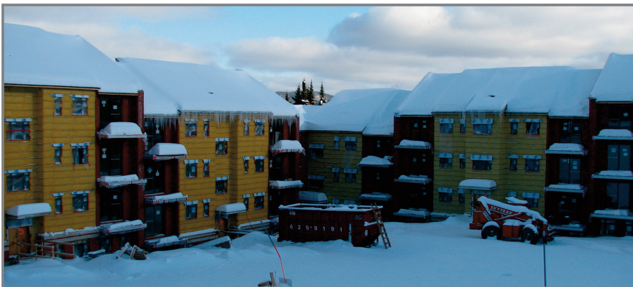
Inter-Loge de Sainte-Adèle, un projet actuellement en construction de 40 logements pour les familles.
