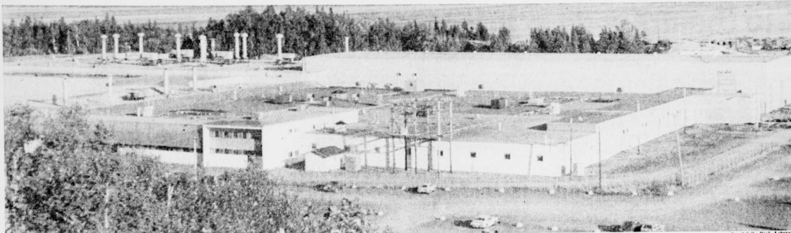
L'usine de Matériel de transport Bombardier, à La Pocatière.
