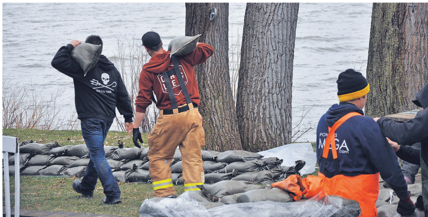
Des sacs de sable ont été empilés aux abords des propriétés riveraines les plus à risque.
