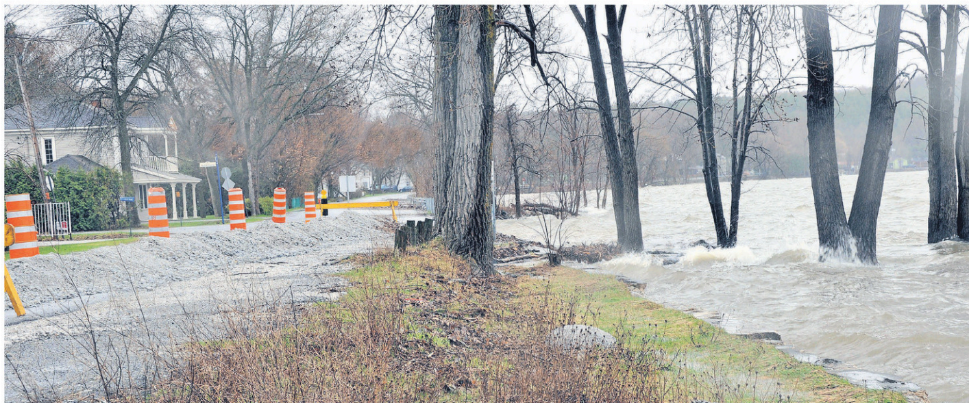
La Municipalité a érigé une petite digue de deux pieds de hauteur et de 200 pieds de longueur afin d'empêcher les vagues de déferler sur l'avenue Champlain. (Photos: gracieuseset - Marie-Hélène Guillemain-Batchelor)
