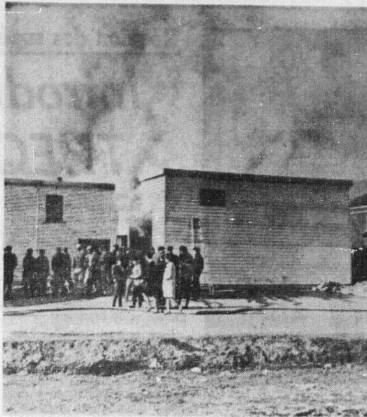
De la fumée s'échappe du magasin coopératif de Tring-Jonction qui a été lourdement endommagé par un incendie, samedi matin. Les pertes sont estimées à $90,000.
