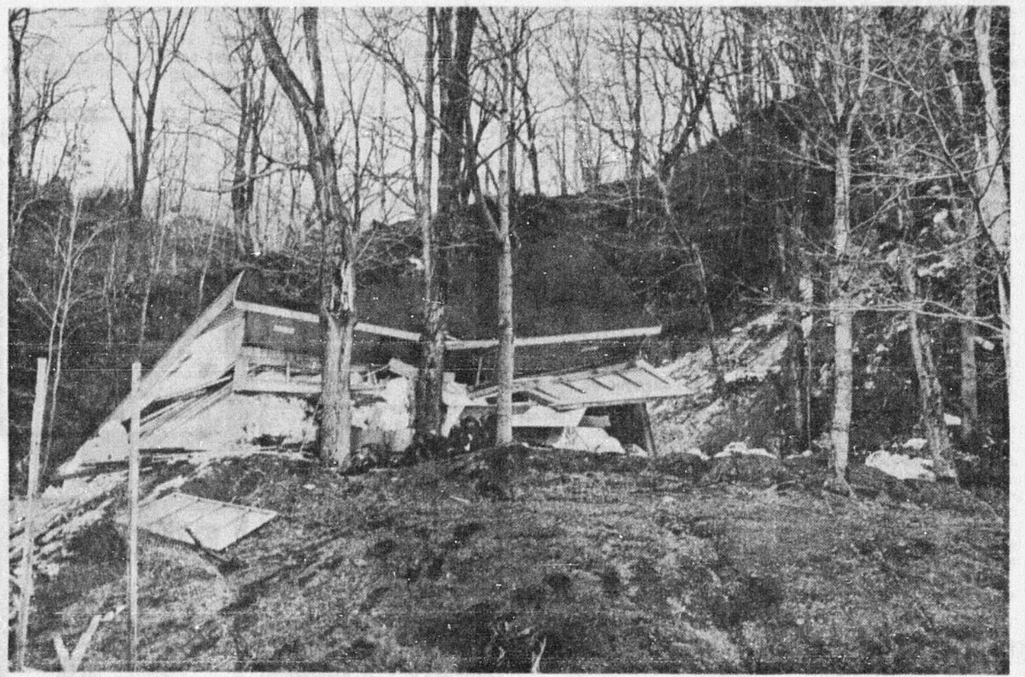
CHALET DEMOLI — Glissant d'une hauteur de quelque 60 pieds, plusieurs tonnes de neige ont démolé samedi après-midi à
