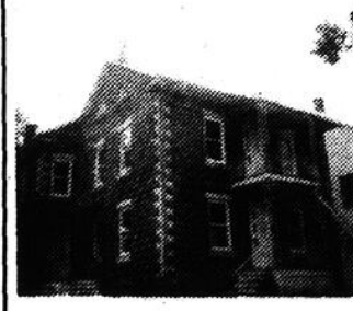
RIVIÈRE-DU-LOUP: rue Richard: Résidence 2 étages de 6 1/2 pièces chacun. Chauffage électrique. Nombreuses rénovations récentes. Prés de tous les services. (5725)
