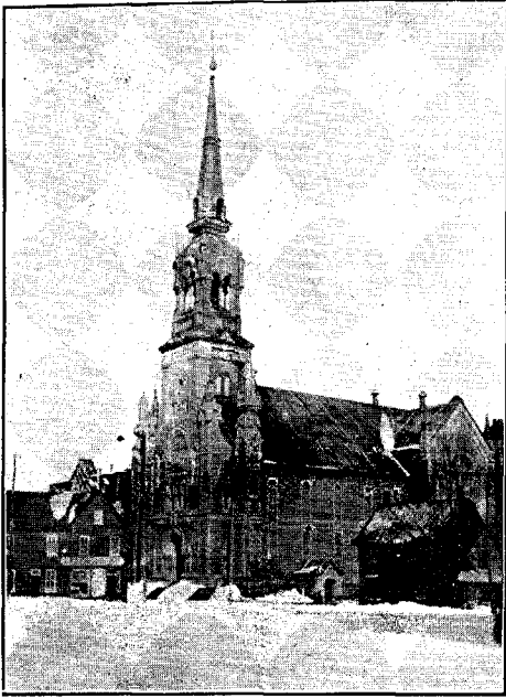
Eglise paroissiale Notre-Dame de Grâce de Hull
