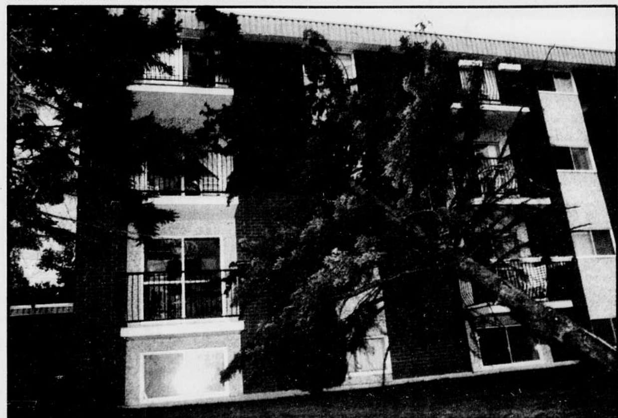
Sous la poussée du vent, un grand arbre s'est effondré contre un immeuble à logements de la rue Dubreuil, à Ascot.
