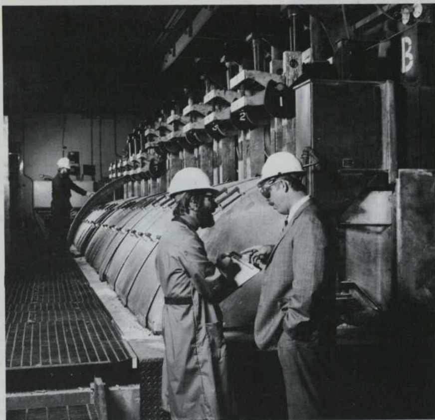
Le prototype final de la nouvelle cuve électrolytique d'Alcan, d'une intensité de 275 kilo-ampères, a été construit et testé en 1984 aux installations de R&D à Jonquière (Québec).
