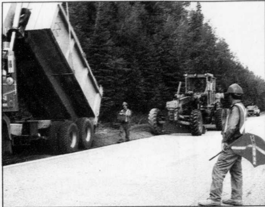
(Photo ABS - Alain Berthiaume) Les seuls travaux envisagés par Transports Québec sur la route 155 nord sont situés à la sortie nord de la ville de La Tuque. Une route de déviation de 300 mètres a été aménagée pour la durée des travaux.
