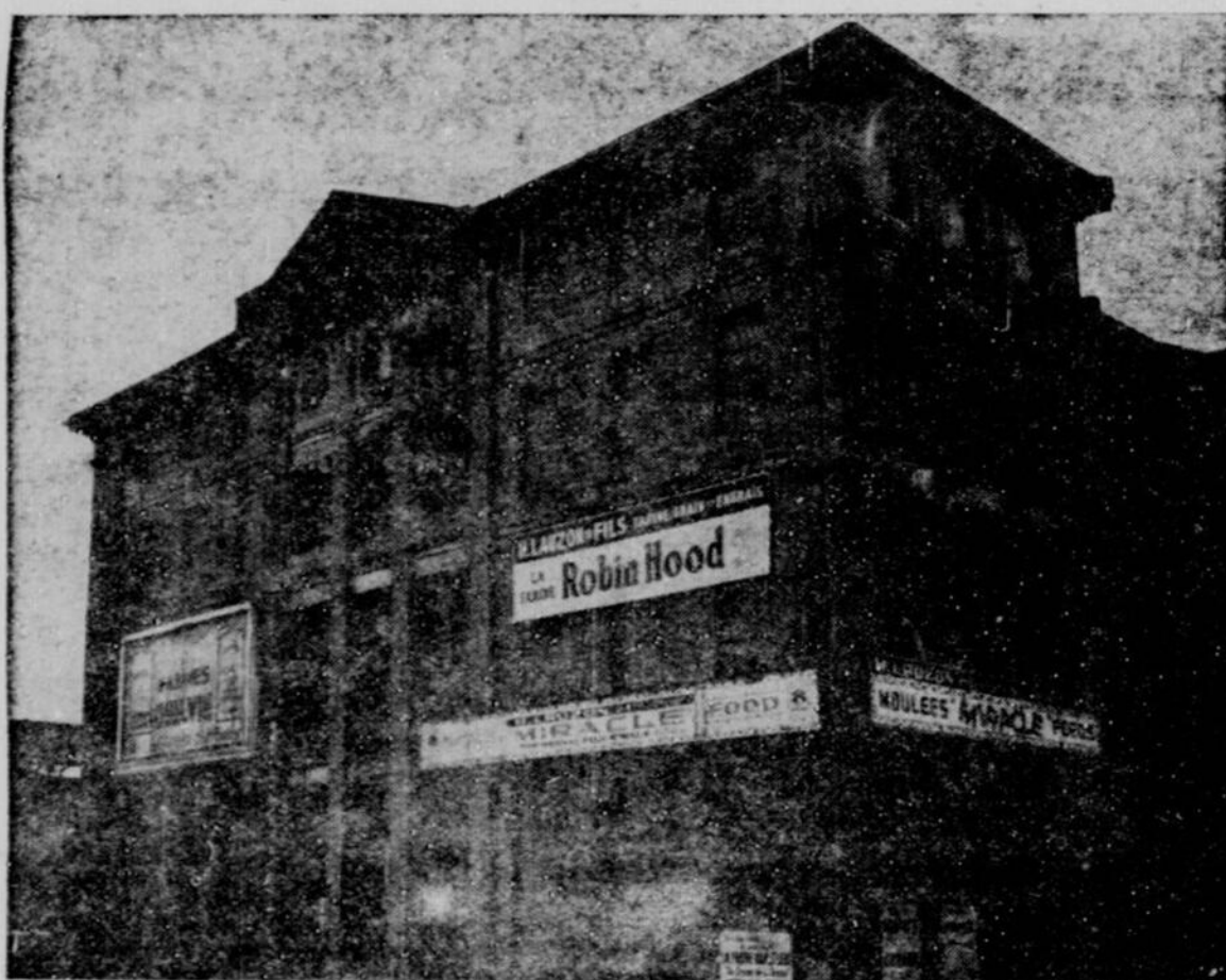
De cet entrepôt de la maison H. Lauzon & Fils, marchands de grains, de farine et d'engrais, situé à 158, est, rue St-Paul, il ne reste plus que les murs calcinés après un violent incendie qui en a ravagé l'intérieur, la nuit dernière, causant des dommages évalués à plusieurs milliers de dollars.
