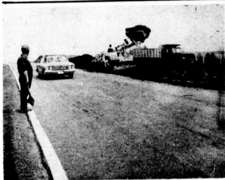
Les travaux sur la route 8 entre Masson et Thurso progressent lentement mais sûrement. Il est certain que la pluie de ces dernières semaines n'a pas favorisé l'accélération des travaux, mais le beau temps étant revenu, on devrait pouvoir reprendre le temps perdu. Il ne faudrait pas oublier que la circulation dense sur cette artère est un autre obstacle à l'exécution rapide de ces travaux. Photo Studio Gleason.
