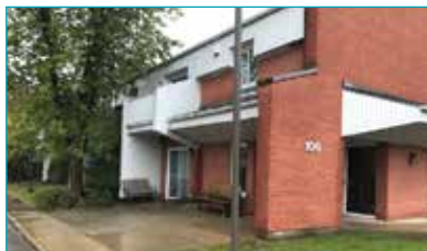
106, chemin Duhamel Immeuble pour aînés autonomes (15 logements)
