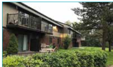
112-114, chemin Duhamel Immeuble pour aînés autonomes (40 logements)
