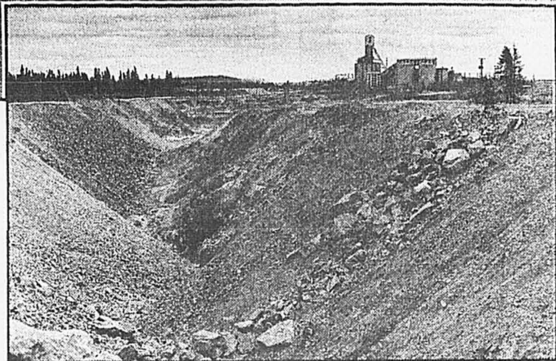
Un ouvrier mort, sorti des décombres en mai 1980. Ci-contre, le site de l'effondrement que Belmoral remplit cette année. On y plantera des arbres.
