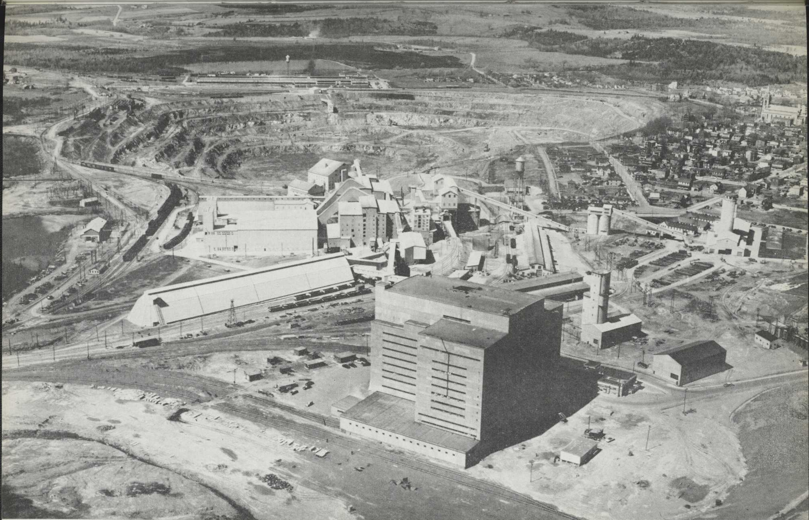
La mine Jeffrey, à Asbestos, est la mine d'amiante la plus importante au monde. Son atelier peut traiter 20,000 tonnes de minerai par jour, et sa capacité annuelle de production est d'environ 625,000 tonnes de fibres d'amiante. Dans cette vue à vol d'oiseau, on remarque, au premier plan, l'usine et les chevalements en béton; à l'arrière plan, la mine à ciel ouvert et la manufacture. Courtoisie de Canadian Johns-Manville Company Ltd. Photo: Photographic Surveys.
