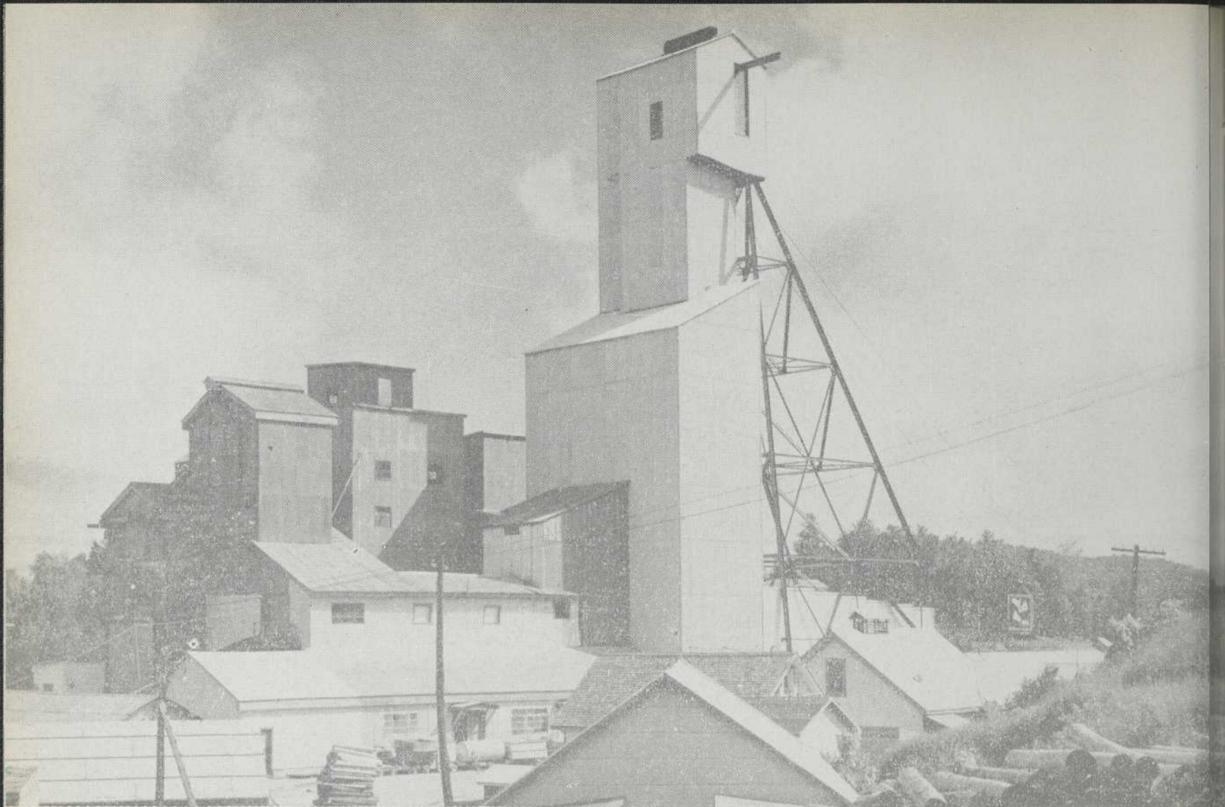
Chevalement et installations de surface de la mine Kilmar, près de Lachute, dans le Sud de Québec. Presque toute la production canadienne de magnésite provient de cette mine. Courtoisie de Canadian Refractories Ltd.
