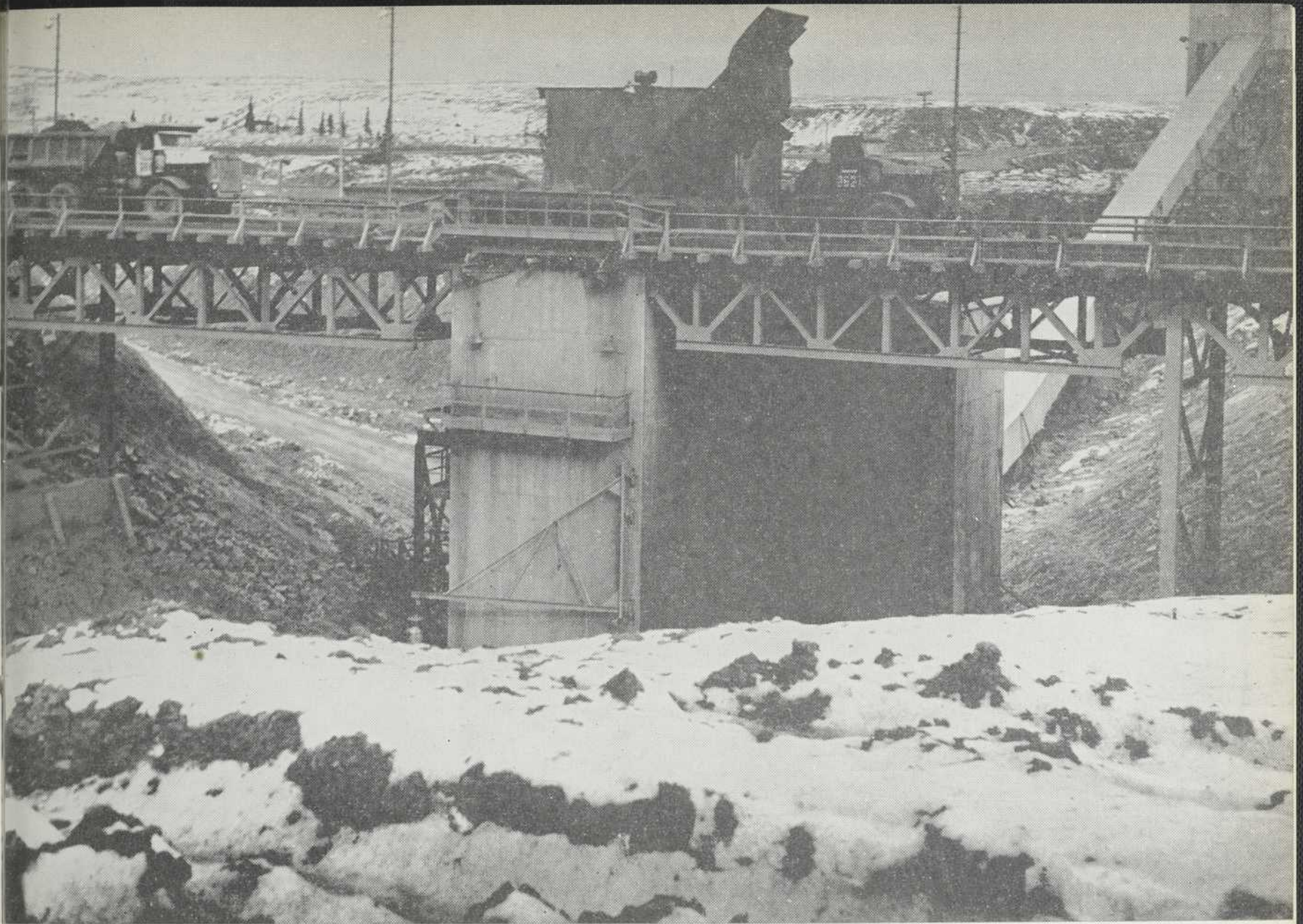
Encore à Schefferville, un camion Diesel déverse du minerai de fer dans un atelier de tamisage de la mine Gagnon. Une courroie transporte le minerai à la trémie de chargement, que l'on aperçoit à droite, au premier plan. Courtoisie d'Iron Ore Company of Canada.
