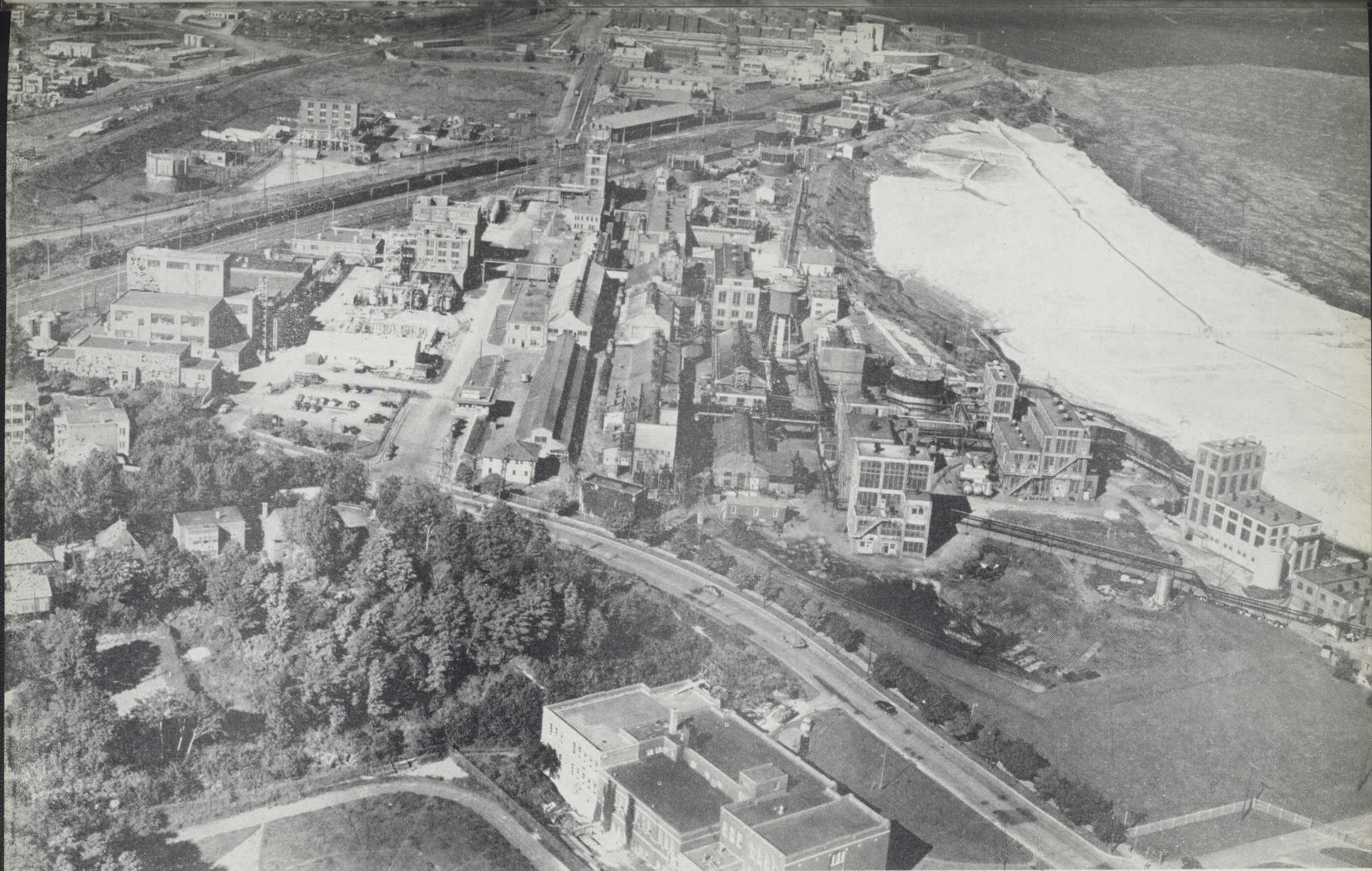
Usine électro-chimique, à Shawinigan Falls. Particulièrement dignes de mention sont les fours électriques qui peuvent produire annuellement 250,000 tonnes de carbure de calcium. Courtoisie de Shawinigan Chemicals Ltd. Photo: Photographic Surveys.
