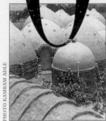
Un détail de l'hôpital de Kaédi, en Mauritanie
