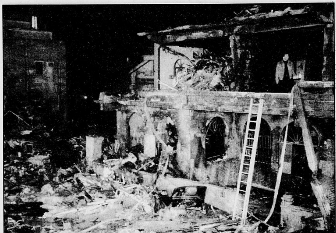
Un avion de China Airlines s'est écrasé sur des habitations près de l'aéroport international de Taïpeh. Aucun passager n'a survécu et neuf personnes ont été tuées au sol. Un résident inspecte ce qui reste de l'immeuble qu'il habitait.
