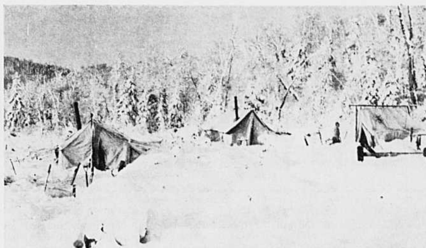
Le tracé, le déblayage et la surveillance de la ligne frontière se poursuit hiver comme été. On voit ici, tout près de Mégantic dans la Province de Québec, un camp d'hiver installé là comme poste de surveillance.
