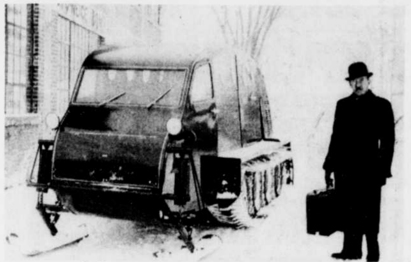
L'inventeur de la motoneige, J. Armand Bombardier, avec son modèle d'auto-neige créé en 1942 pour l'armée canadienne. Ce véhicule pouvait transporter 12 passagers. (Lasserphoto PC)
