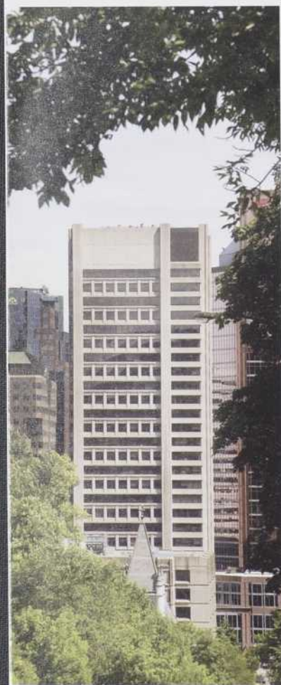
L'édifice de l'OACI, rue Sherbrooke ouest
