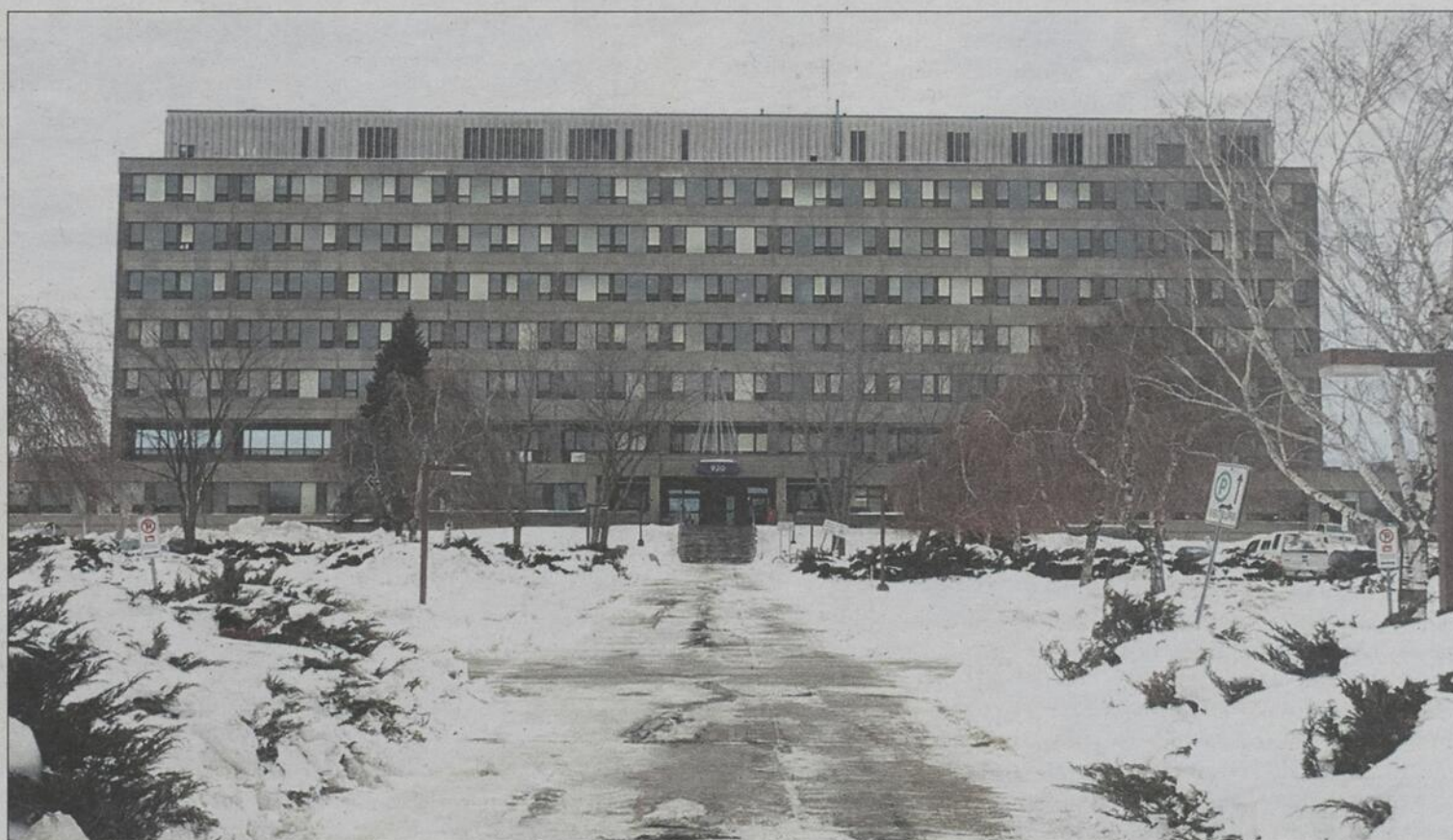
Le quatrième étage de l'Hôpital du Haut-Richelieu ainsi qu'une partie du rez-de-chaussée et du sous-sol sont munis de gicleurs.
