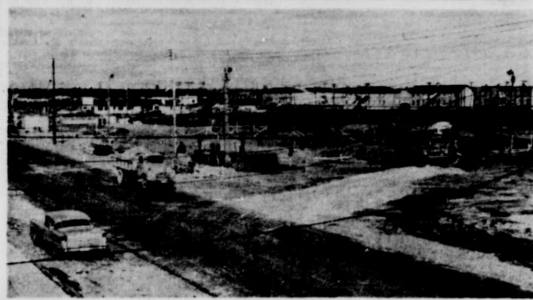
L'UNE DES PLUS IMPORTANTES CONSTRUCTIONS en cours dans notre ville, actuellement, est celle de l'Institut de Technologie. Construit sous l'égide du ministère de la Jeunesse et du Bien-Etre Social de la province, le futur édifice s'éleva sur la rue de Courval et sera l'un des plus vastes et des mieux aménagés au pays. Le contrat général a été confié à Pagé Construction, de notre ville. Le terrassement est terminé et les travaux des fondations se déroulent présentement. La photo ci-dessus donne une idée de l'envergure des travaux.
