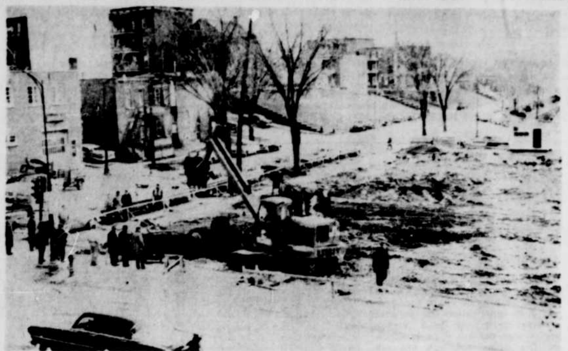
LES TRAVAUX D'EXCAVATION sur l'emplacement du futur édifice fédéral, dans le triangle des rues de la Station, et St-Maurice, ont commencé hier. Ce sous-contrat a été confié à Laurentide Ready-Mix. La besogne n'est pas facile, car comme on le sait sans doute, on avait tout simplement enfoncé les fondations et fait un peu de nivelage, après que les bâtisses eurent été démolies à cet endroit.
