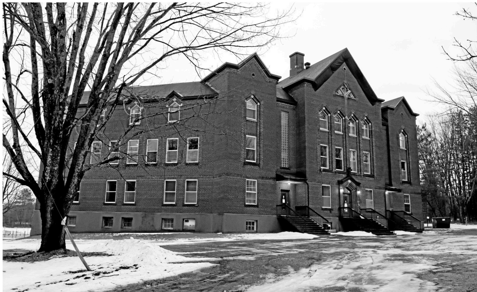
Dans le cas des frères de Sainte-Croix, les agressions auraient été commises à l'orphelinat de Waterville (sur la photo) ainsi que dans une école de Thetford Mines, entre les années 1940 et 1970. — PHOTO SPECTRE MÉDIA, JESSICA GARNEAU
