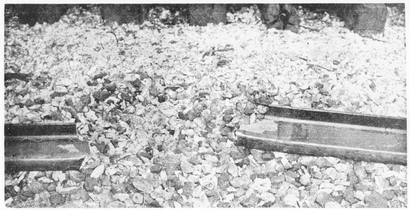
DYNAMITAGE. Tronçon de rail sectionné et égrené par la dynamite près de Manseau.
