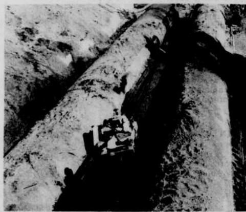
D'importants travaux de voirie exécutés par Alma sont présentement en cours depuis quelques semaines dans le secteur du Boul. Auger ouest. Les travaux de l'ordre de $40,000 consistent à remplacer trois ponceaux de 84 pouces de large et d'une longueur de plusieurs centaines de pieds qui permettront d'évacuer les eaux du Ruisseau Rouge qui passe sous le Boul. Auger. Un affaissement de terrain au printemps dernier avec nécessité le remplacement des ponceaux déjà existants.
