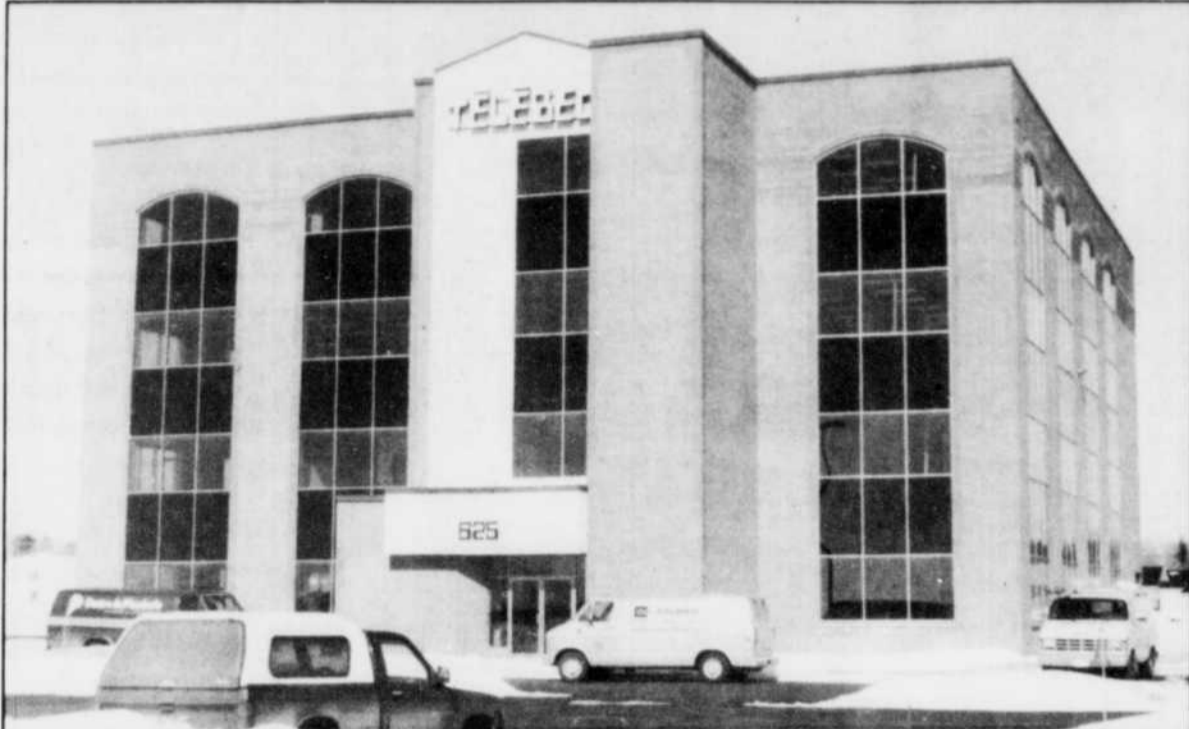
Dès le lundi 18 mars, les 200 employés du siège régional de Télébec occuperont leur nouvelle bâtisse construite à Bécancour, à la sortie du pont Lavolette.
