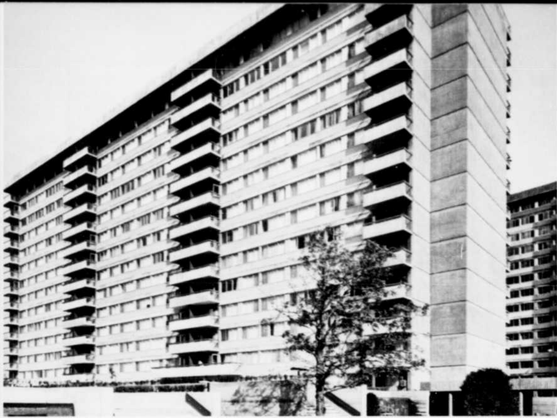
1. Immeuble moderne en béton monolithique à Ville Saint-Laurent (Québec).
