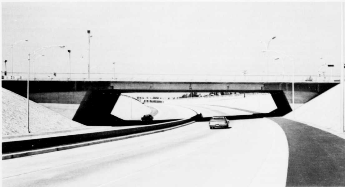
6. Nouveau pont en béton enjambant l'autoroute Papineau-Leblanc à Laval, dans la banlieue de Montréal.
