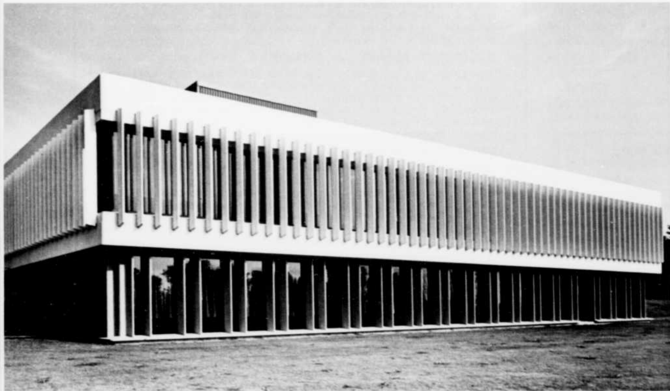
4. Construction en béton préfabriqué pour le bâtiment de Burroughs Wellcome à La Salle (Québec).
