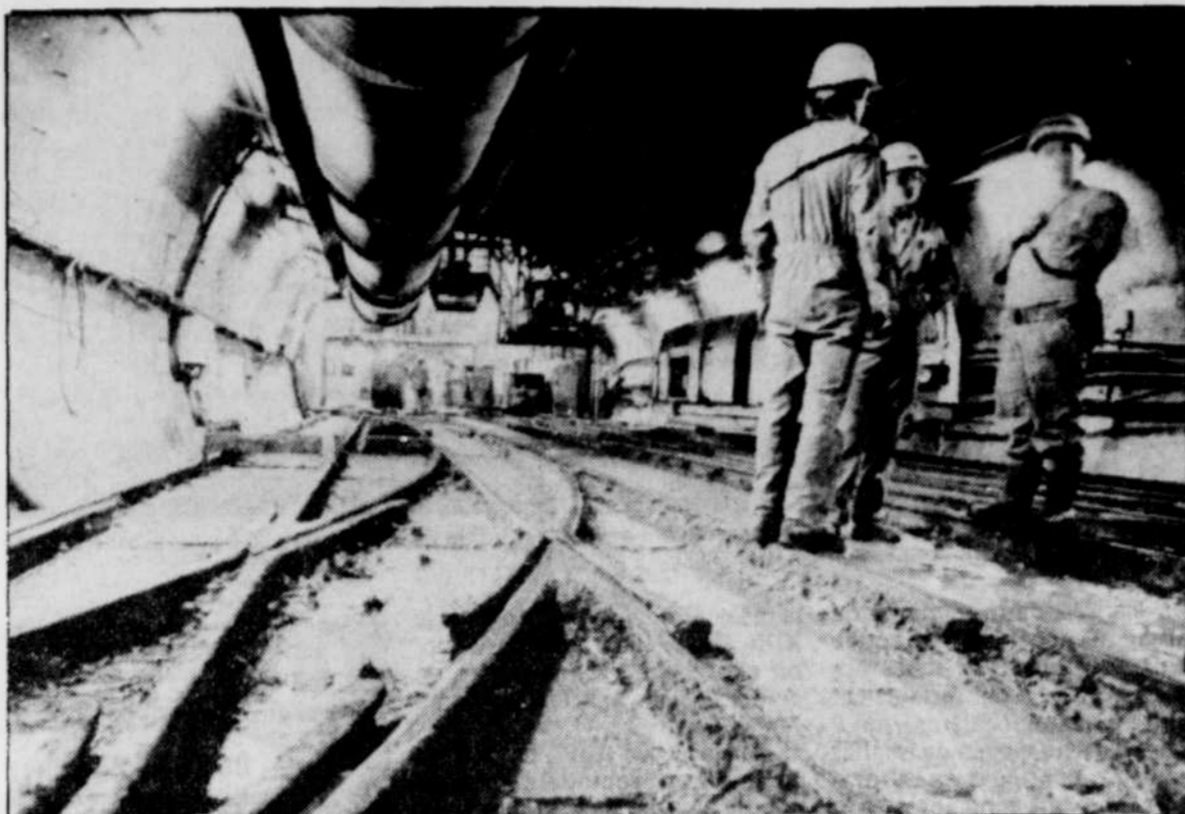
Les automobilistes pourront emprunter le tunnel sous la Manche à l'été 1994 mais les autocars devront attendre le mois de septembre.
