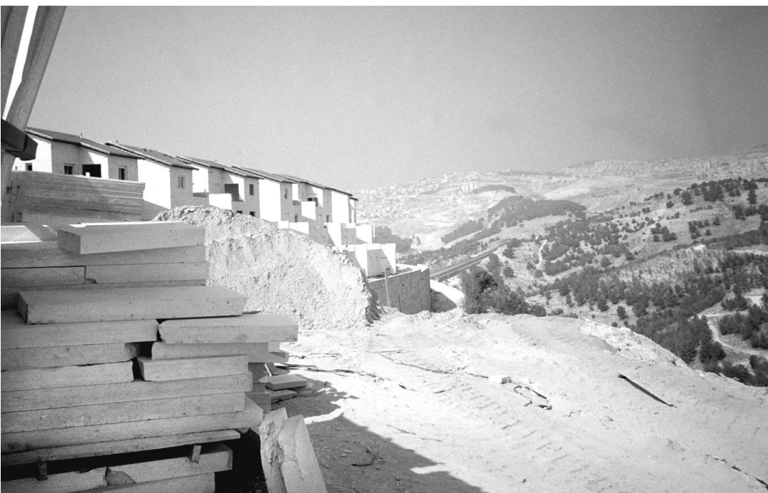
À Ma'ale Adoumim, la construction va bon train.
