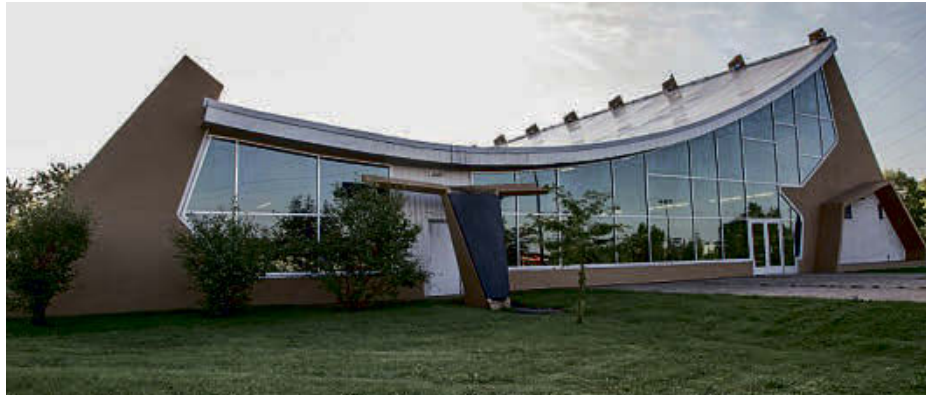
La toiture de la piscine Laurier-R.-Ménard sera refaite à cause de travaux bâclés il y a quelques années. Photothèque | Les 2 Rives ©
