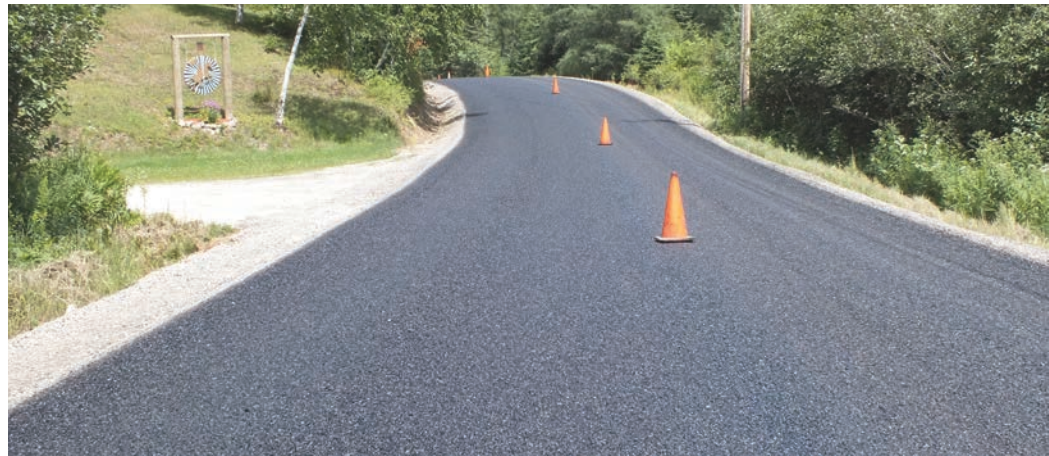
Traitement de surface recouvert d'un scellant bitumineux
