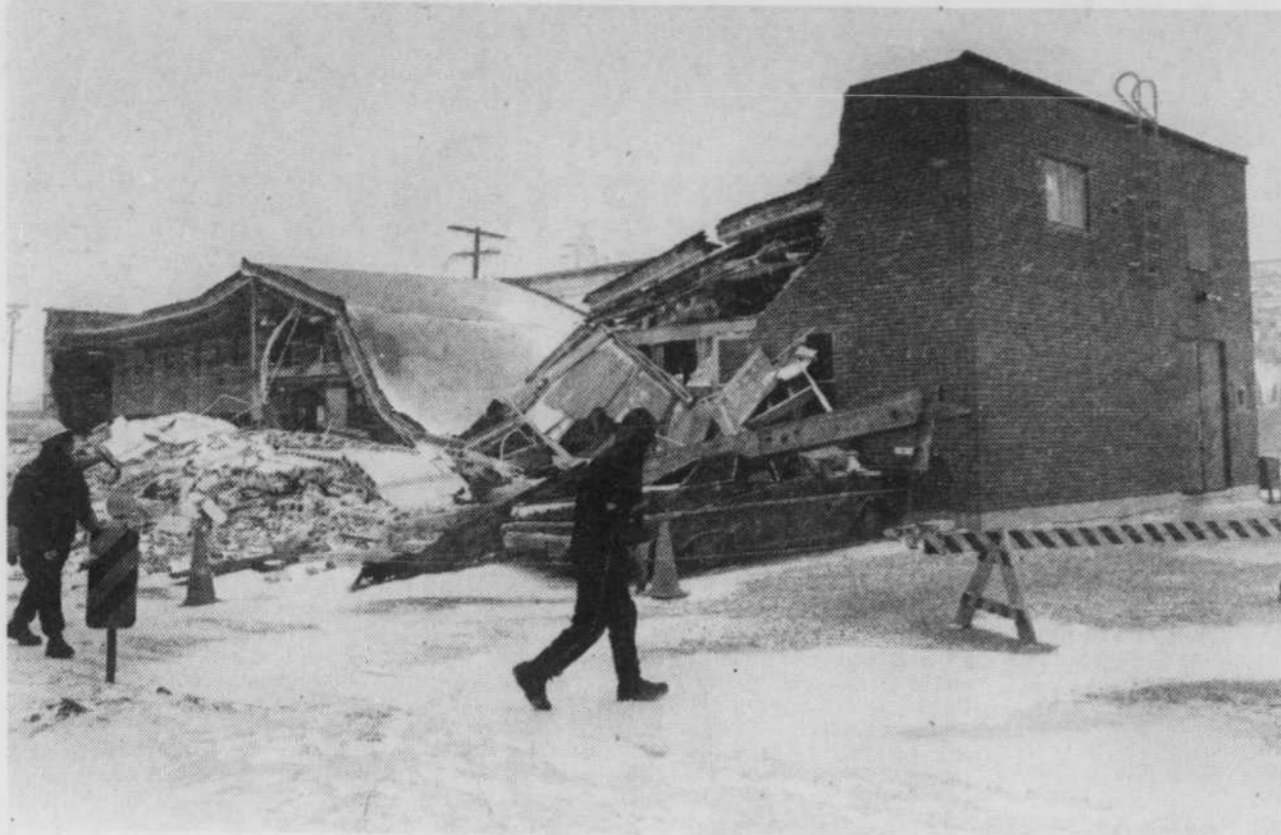
Cette photo illustre éloquentement la violence avec laquelle un transformateur a explosé hier matin, détruisant complètement le poste Charland de l'Hydro-Québec dans le nord de la ville. (Photo Le Devoir, par Alain Renaud)
