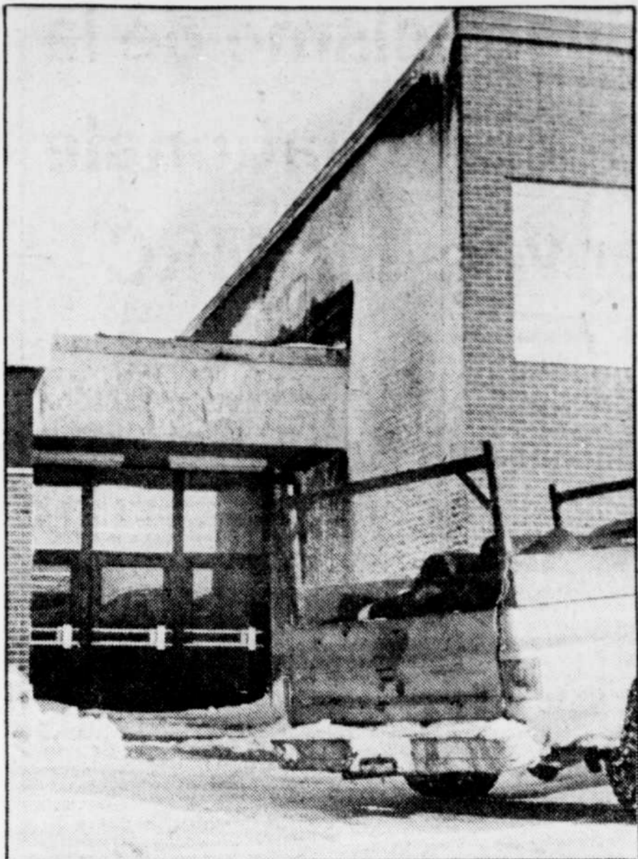
L'entrée de la section des ateliers a été réparée.
