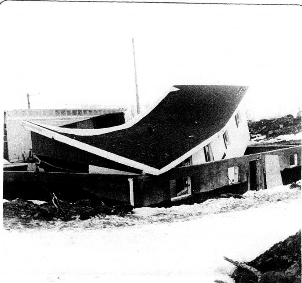
UNE MOITIE DE CATASTROPHE. — Cette moitié de maison sectionnelle pré-usinée s'est effondrée dans la cave alors même qu'on procédait à son installation, jeudi dernier, sur la 6ième rue à Montmagny. Un ouvrier a été blessé dans cet accident de travail; il s'agit de M. Antoine Pouliot, de St-Joseph de Beauce, qui fut transporté par les ambulanciers de la Maison Laurent Normand, de Montmagny, à l'Hôpital St-Sacrement de Québec. (C.M.—PEUPLE—COURRIER)
