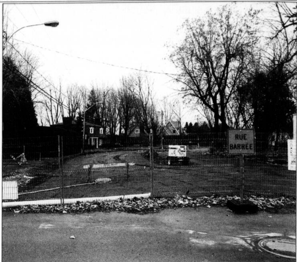
L'intersection de la 1 re Rue et de la 15 e Avenue sera accessible. Il y aura vraisemblablement des entraves à la circulation et la chaussée restera en gravier.
