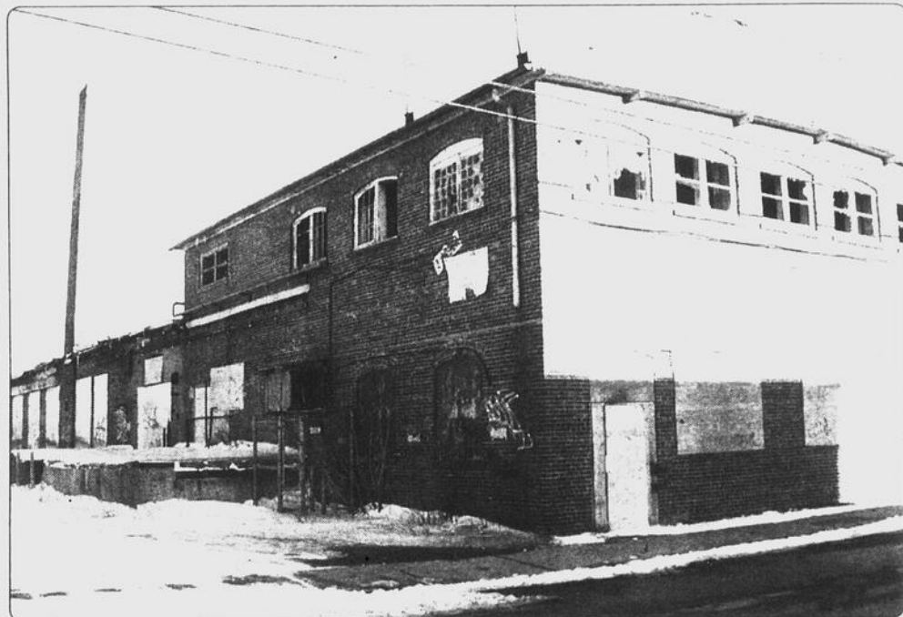
Depuis janvier, c'est la quatrième fois que les pompiers se rendent dans l'édifice désaffecté.
