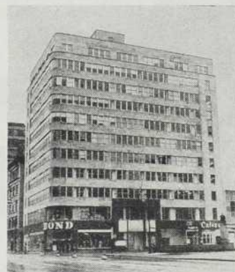
Les Travaux de Plâtrage au nouvel édifice Phillips Square et au Noviciat des FF. Ste-Croix à Carillon, ont été exécutés par
