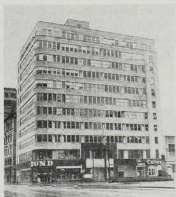
Les travaux de couverture pour le nouvel édifice Phillips square, l'édifice Pascal et le MacVicar Memorial Presbyterian Church ont été confiés à:
