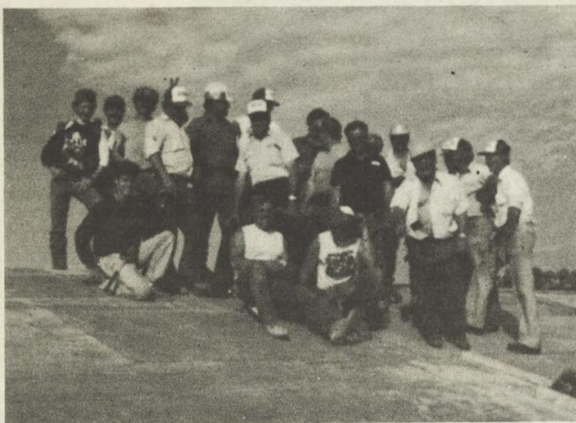
26 personnes ont donné bénévolement de leur temps pour aider aux travaux d'agrandissement de la caisse populaire de St-Pierre. En voici quelques-uns qui posent fièrement sur le toit qu'ils ont érigé en une seule journée.
