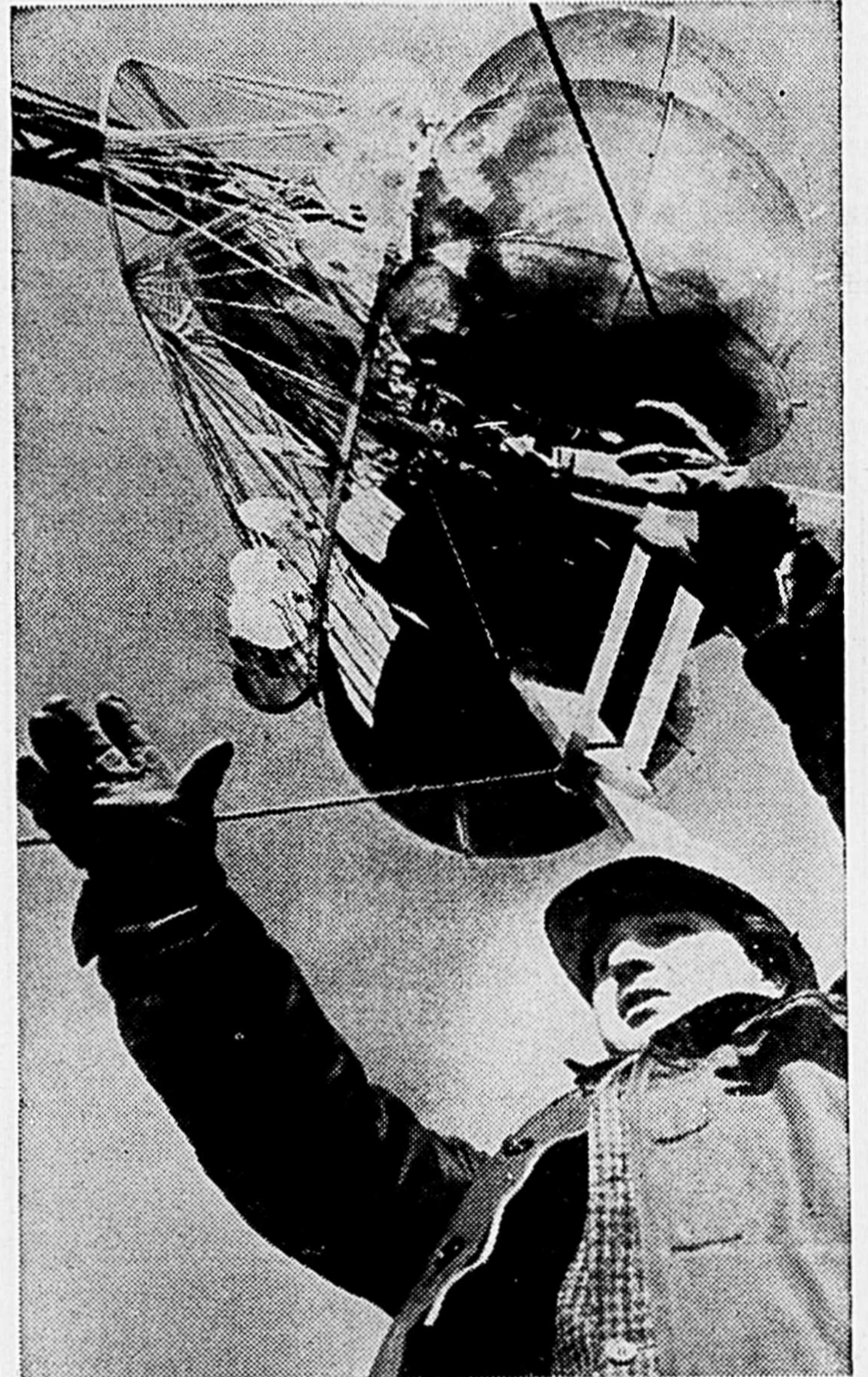
Voici le sculpteur Gerald Gladstone, de Toronto, en train de diriger la grue au moment où son oeuvre, une sculpture-fontaine, est mise en place à la Place des Ingénieurs de l'Expo 67.
