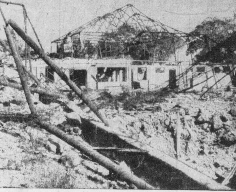
Les bombes japonaises ont détruit, le 29 décembre dernier, les quartiers des officiers américains dans l'île de Corregidor qui garde l'entrée de la baie de Manille. On voit sur cette vignette l'étendue des dégâts causés par les aviateurs ennemis qui n'ont laissé que des ruines sur leur passage.
