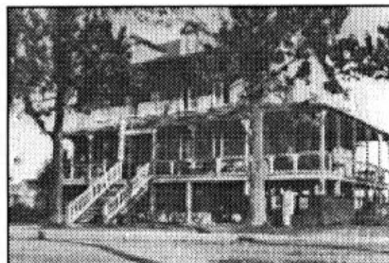
Maison construite en 1833 par le marchand Élie Martin; devint le Ely's Boarding House vers 1850 avec Thomas Ely puis l'hôtel Joffre vers 1890; transformée depuis (105 Principale O.). Coll. famille Antonio Sirois.
