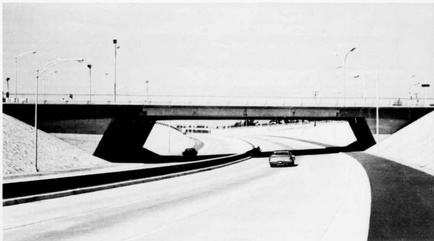
6. Nouveau pont en béton enjambant l'autoroute Papineau-Leblanc à Laval, dans la banlieue de Montréal.
