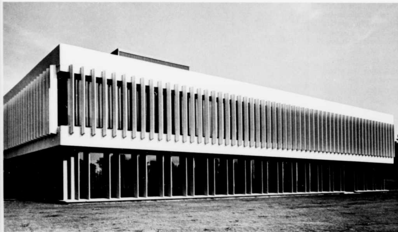
4. Construction en béton préfabriqué pour le bâtiment de Burroughs Wellcome à La Salle (Québec).
