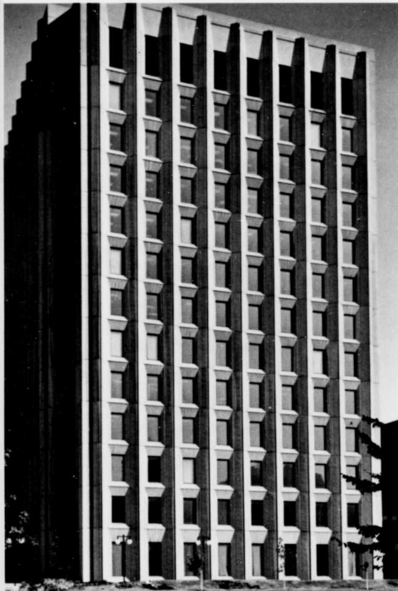
2. Cet édifice de l'université McGill, Montréal, met en relief les panneaux de béton préfabriqué.
