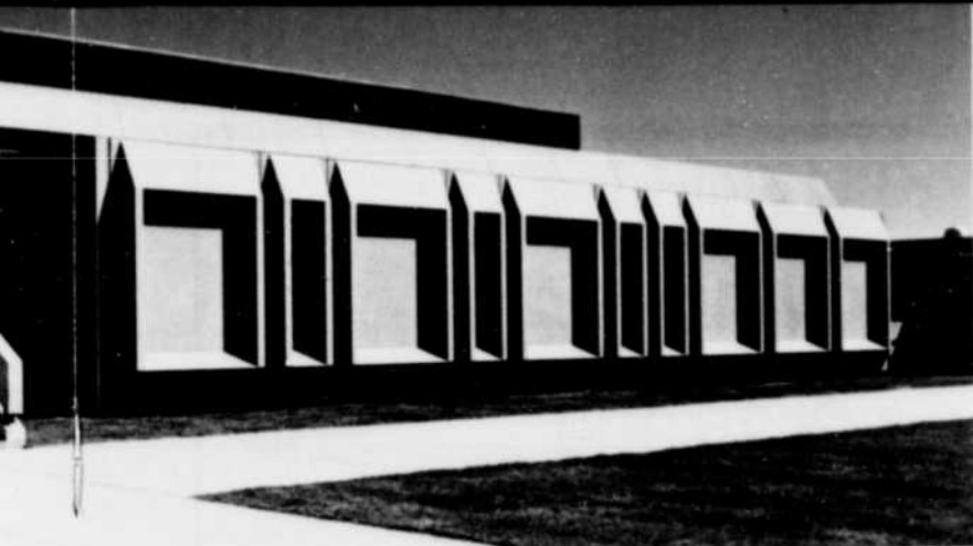
...gation et de permanence, cette école secondaire de Beauharnois, Qué., est en béton.
