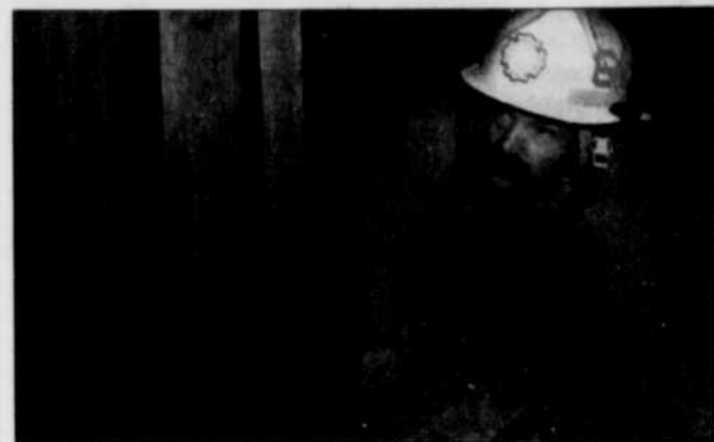
À cause de l'instabilité de la bâtisse les secouristes avancent à pas de tortue.
