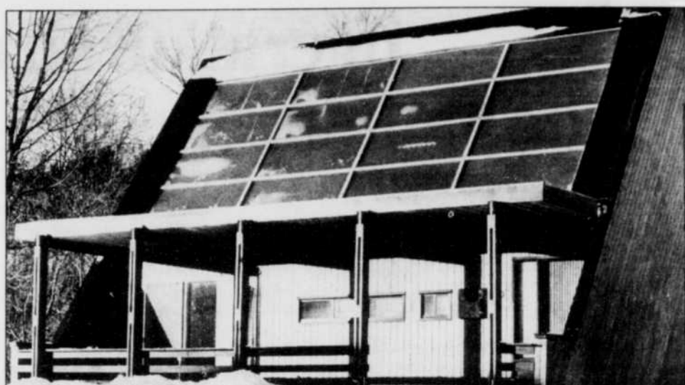
Maison chauffée à l'énergie solaire. En haut, ses panneaux capteurs. Équipé de la sorte, on se serait sans doute gaussé des pannes d'électricité résultant du verglas.
