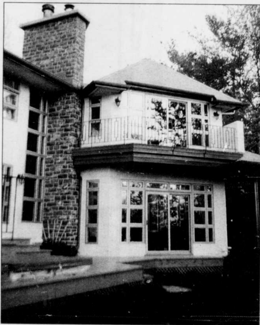
On peut tenir pour esthétiquement terne une porte «patio». Mais, on peut l'embellir, lui donner même de l'élevation architecturale. Comme le fait, ici, l'architecte René Saillant.
