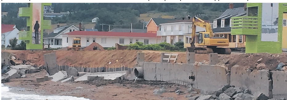
Le rechargement de plage se fera sur une distance d'environ 900 mètres, entre le quai de Percé et le Riôtel. Le littoral retrouvera son état naturel, semblable à ce qui prévalait avant la construction d'un mur artificiel de protection. (Photo Le Pharillon - Jean-Philippe Thibault)
