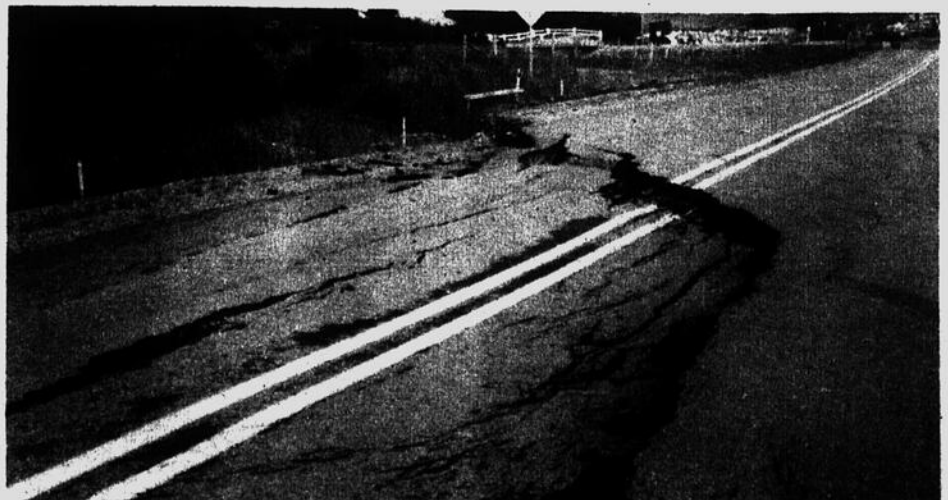
1er JUILLET: La route reliant Lac-Drolet à St-Ludger est fermée à la circulation l'affaissement a pratiquement doublé depuis le 3 juin.
