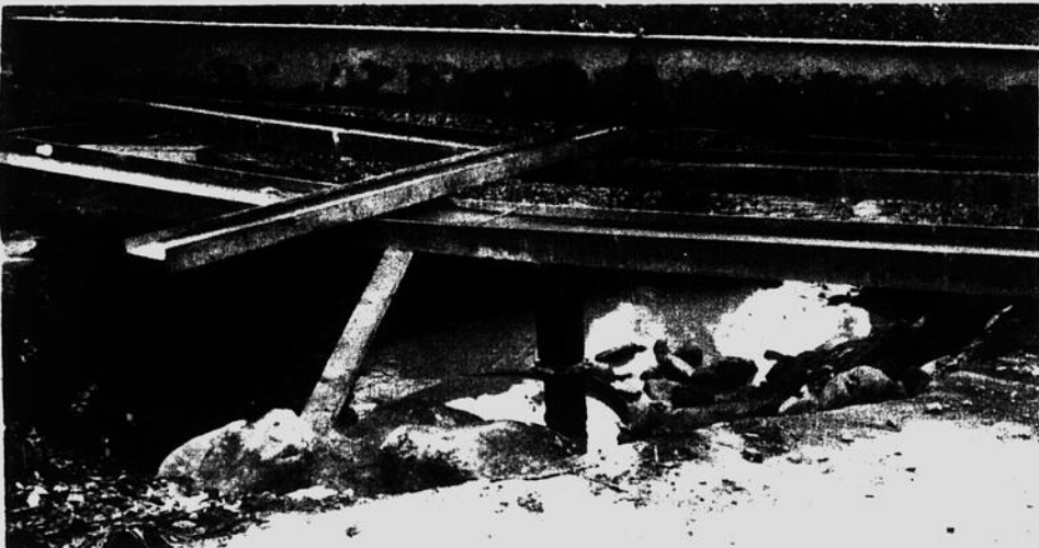
10 JUIN: une deuxième expérience pour vider le puits; on a coulé une couronne de maçonnerie mais le bouchon n'a pu résister à la pression.
