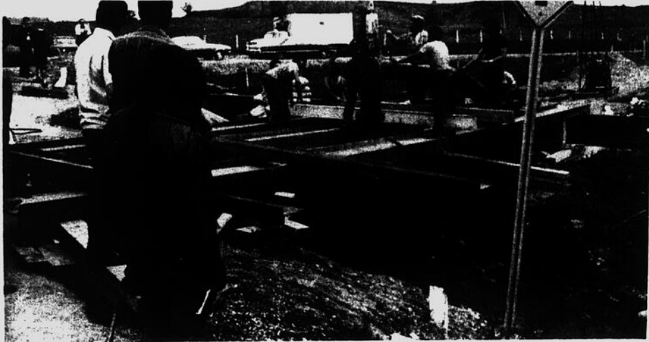
4 JUIN: le puits tel qu'il apparaissait; le débit d'eau argileuse est constant; on se prépare à une première tentative pour vider le puits.
